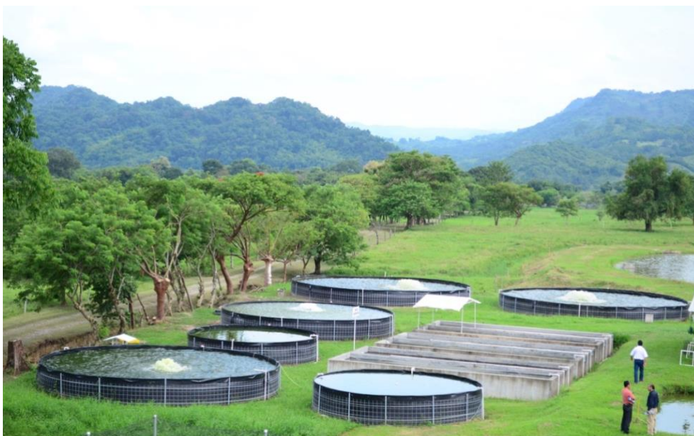
Figura 3. Estanques de geomembrana
