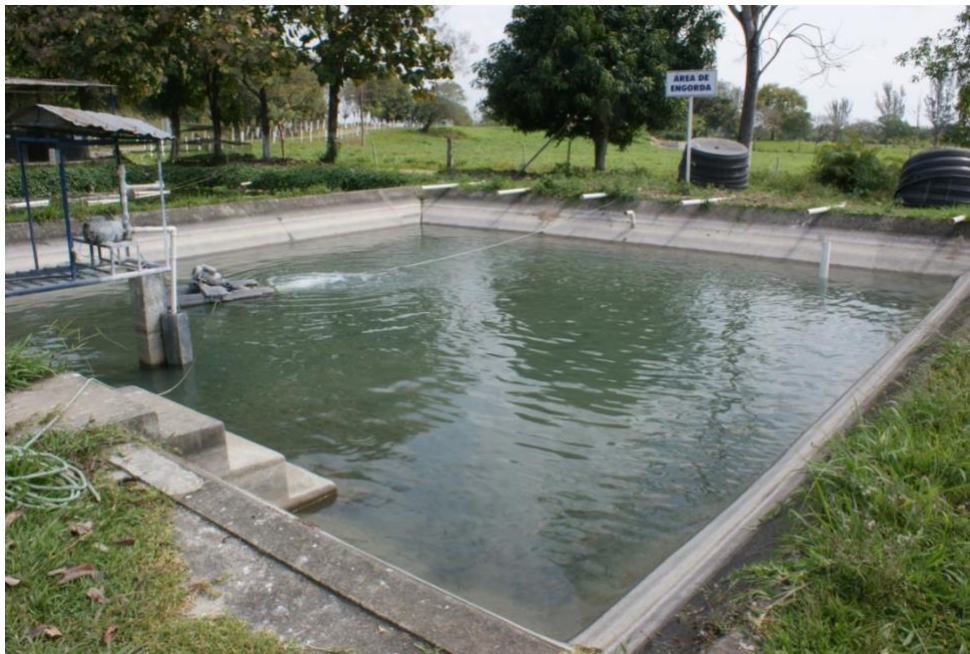
Figura 2. Estanque de concreto.
