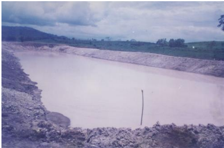
Estanque rústico en construcción, 1988.
