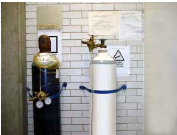
Una de las recomendaciones de las Comisiones Mixtas es que los tanques de gases se encuentren bien sujetos
