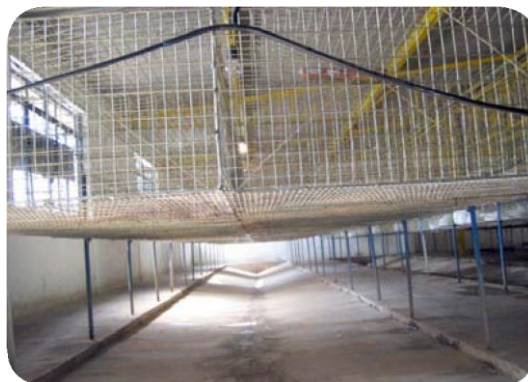
Figura 1.2. Observación de factores técnicos internos como la inclinación de los pisos. Fuente: CEIEPAV
