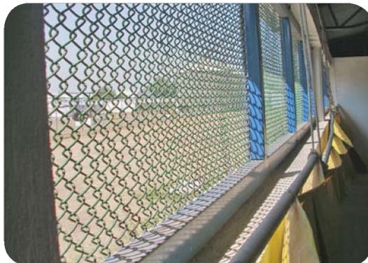
Figura 2.3. Ventanas con mallas protectoras
