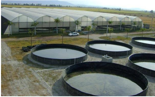
Ilustración 23 Estanques de geomembrana
