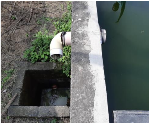
Ilustración 32 Salida del agua del estanque al sedimentador
