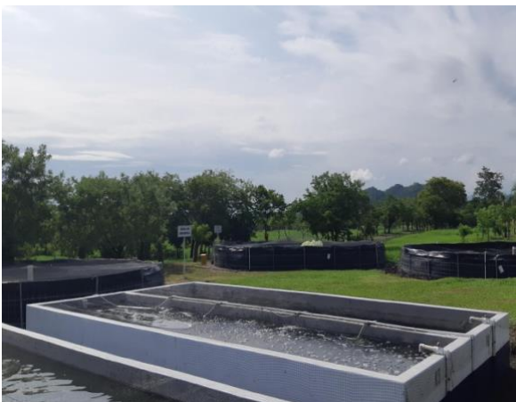
Ilustración 22 Estanque cementado con aireación y de geomembrana
