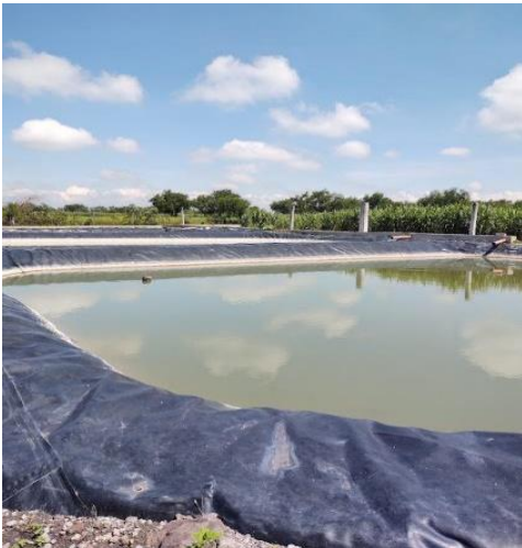
Ilustración 21 Estanque recubierto con geomembrana
