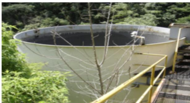
Figura 1a. Tanque de agua de reproceso bombeada desde la presa de jales [19]
